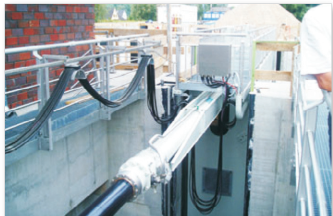
Cửa chuyển đổi trực ngang của âu thuyền Tatenberg với xy lanh thủy lực biên độ 13m
