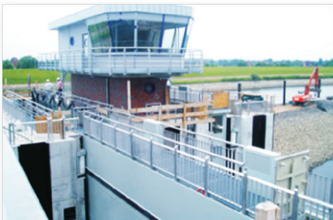
Cửa chuyển đổi trực ngang của âu thuyền Tatenberg với xy lanh thủy lực biên độ 13m
